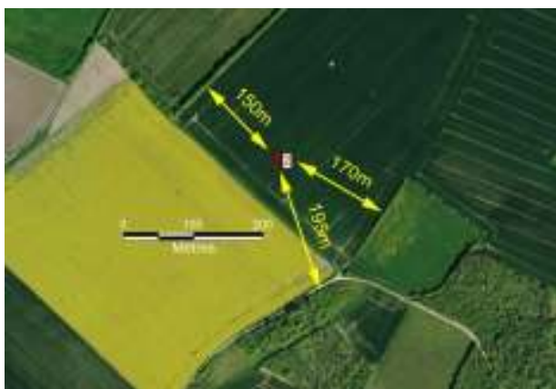
Figure 265 : Position de l'éolienne 2 par rapport aux haies et lisières proches (source : Les Snats, 2017)
